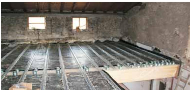
Solaio rinforzato con Connettore FLAP® ribassati specificatamente per le travi complanari e Traliccio LPR® continuo sulla trave
