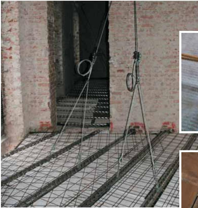
Solaio rinforzato con pannelli di isolante interposti fra il tralicci, rete elettrosaldata prima del getto in CLS
