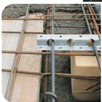
Particolare interfaccia cordolo-solaio con Traliccio LPR® che assicura un ottimo ammortamento indispensabile in zona sismica.
