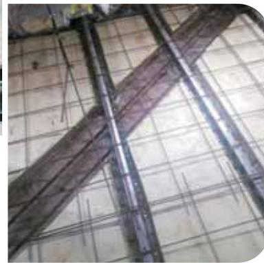
Correa d'irrigidimento d'angolo solaio per effetto piastra
