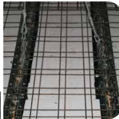
Particolare del rinforzo con Traliccio LPR® rovescio, pannelli di polistirolo inseriti fra i travi e rete elettrosaldata diametro 6 mm maglia 20x20
